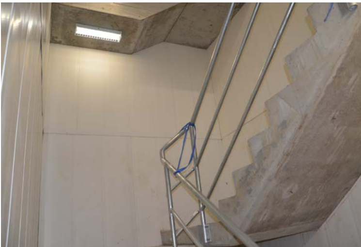
Dintel Stair Walls
