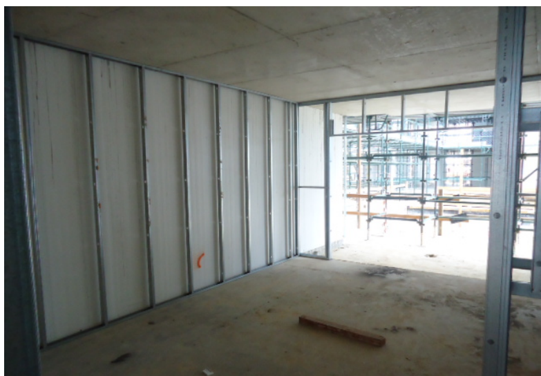
Internal Dintel Walls
